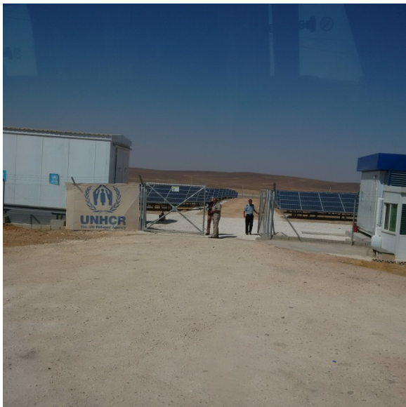
(solare 2MW Freiflächenanlage zur Stromversorgung im Azraq-Flüchtlingscamp)
