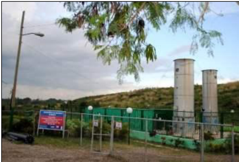
Abbildung 4.7: Anlage auf der Calle 100
