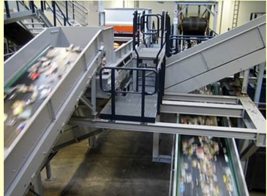
(Recyclinganlage in Gütersloh von Bamberger)
